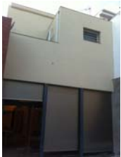
Reforma de vivienda unifamiliar en C/Santa Maria 108 (Badalona)
