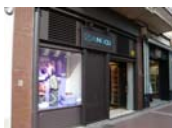
Reforma Local comercial para tienda de ropa Z and CO en la C/León XIII 20 de Zaragoza.
