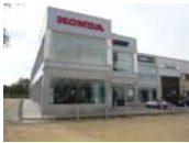
Reforma de Concesionario de Maquinaria Honda en Mairena de Aljarafe (Sevilla)
