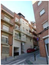
Rehabilitación de edificio plurifamiliar en la C/Sostres 1-bis (Barcelona)
