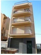
Rehabilitación de edificio plurifamiliar en la C/Pasteur 48 (Barcelona)
